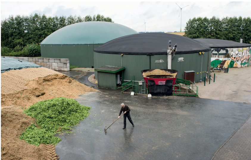
Biogasanlagen haben große versiegelte Flächen, auf denen nach Regenereignissen organisch belastetes Wasser anfallen kann. Dafür wurde im Projekt BGA-FLEXBIO eine kostengünstige Technik zur Aufreinigung entwickelt. Foto: FNR/D. Hagenguth
