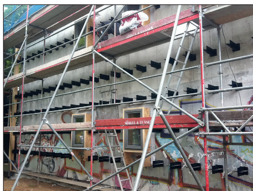
Im Bauprojekt „Alte Brauerei“ in Schwerin entstehen über 120 Wohneinheiten, die fast alle eine Strohballendämmung erhalten. Der Bauherr entwickelte hierfür ein Halterungssystem aus Recycling-Kunststoff (I.), mit dem sich die Ballen effizient auf den Fassaden fixieren lassen.
