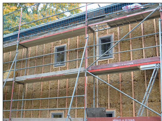
Im Bauprojekt „Alte Brauerei“ in Schwerin entstehen über 120 Wohneinheiten, die fast alle eine Strohballendämmung erhalten. Der Bauherr entwickelte hierfür ein Halterungssystem aus Recycling-Kunststoff (I.), mit dem sich die Ballen effizient auf den Fassaden fixieren lassen.
