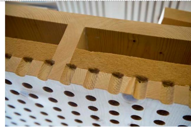
Den Einsatz von Dämmstoffen aus nachwachsenden Rohstoffen – wie hier Holzfaserverplatten für den Schallschutz – erlaubt die M-HFH HolzR nicht; sie bedürfen der Einzelfallgenehmigung
