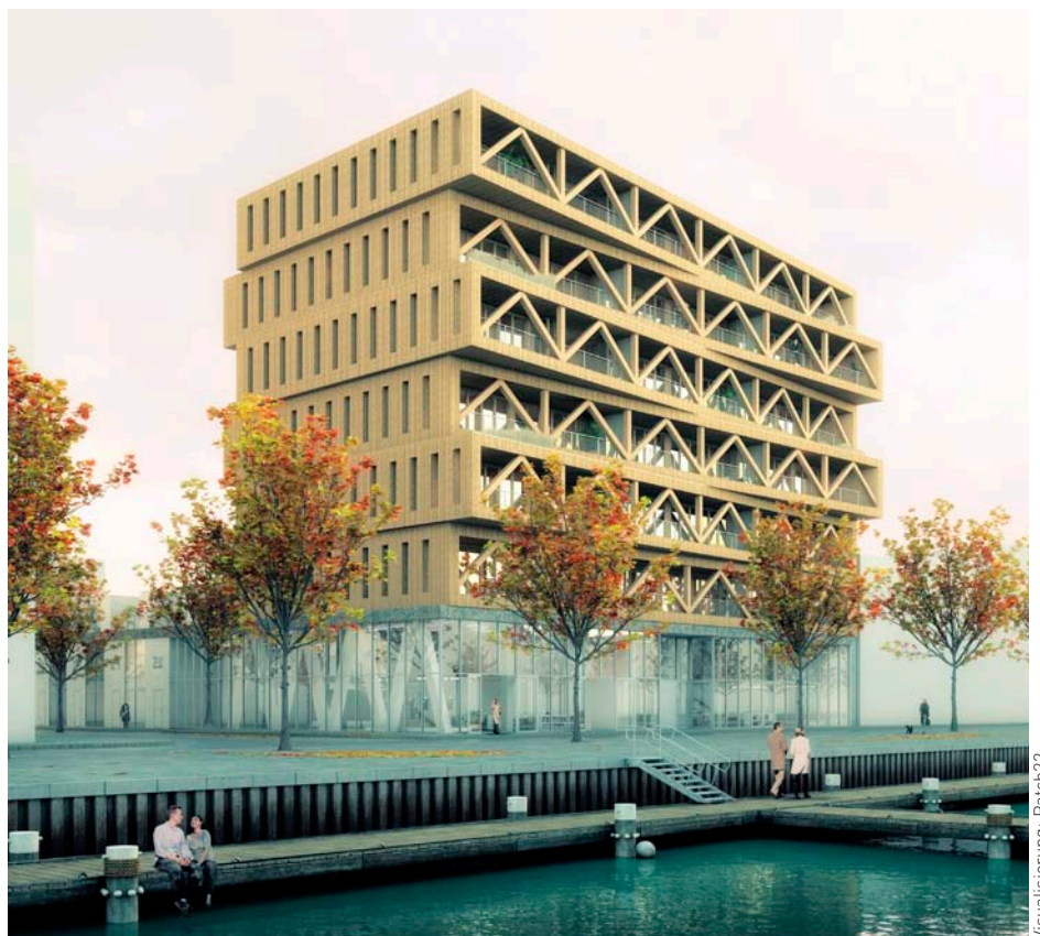
Hollands höchster Holzbau: Sechs der sieben Geschosse entstehen aus vorgefertigten Holzelementen. Architekten: Frantzen et al architecten
