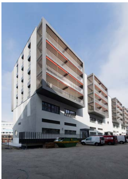
In Zürich wurden bei einem Bahngelände auf zwei massiv gebauten Sockelgeschossen vier Etagen in Holzbauweise aufgestockt
