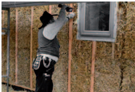
Strohballenhalter, vorgefertigte Bauteile und deren Einsatz in der „Alten Brauerei“ in Schwerin.
