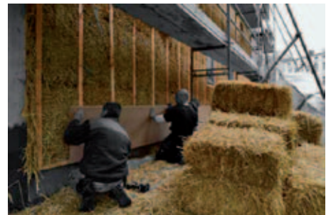
Strohballenhalter, vorgefertigte Bauteile und deren Einsatz in der „Alten Brauerei“ in Schwerin.
