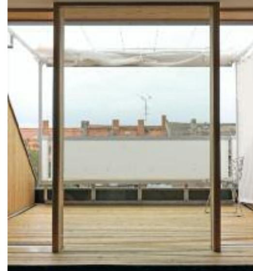
Eine der beiden verschatteten Terrassen, über die in der Nacht kühlere Luft nachströmt. Die Zwischendecke ist an einem Stahlträger aufgehängt. Die Galerie auf der Zwischendecke dient als Lagerraum.
