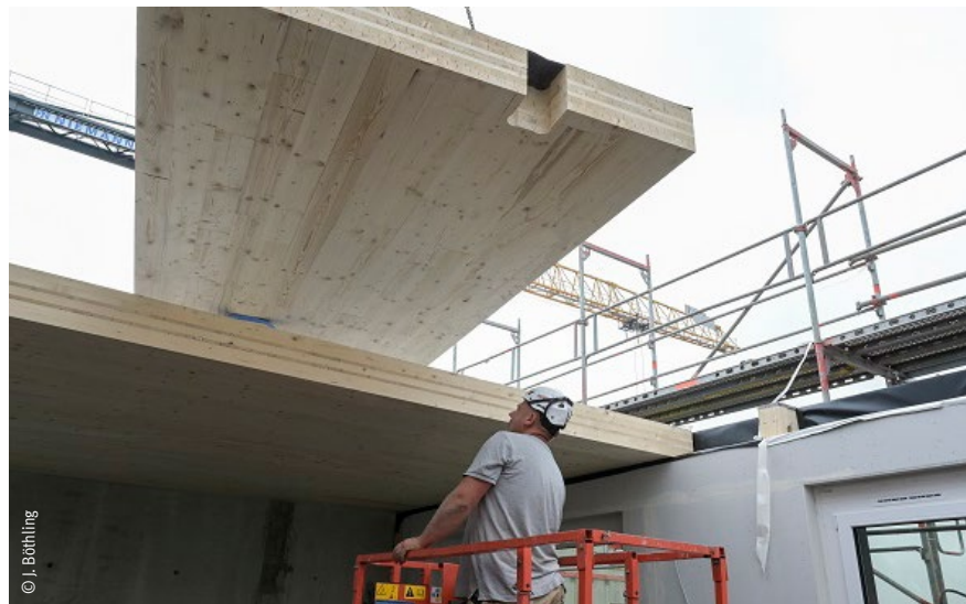
Einbau einer Zwischendecke im Holzhochhaus roots in der Hamburger Hafencity
