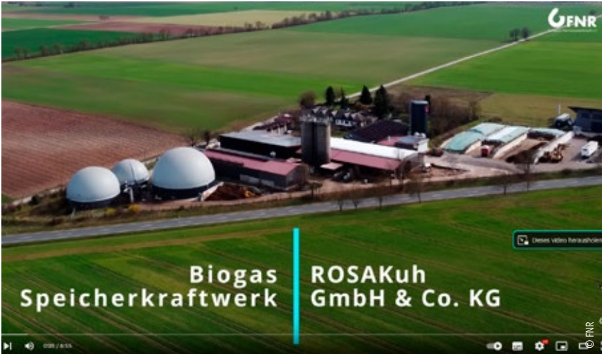
Eines der Video-Praxisbeispiele für zukunftsweisend flexibilisierte Biogasanlagen
