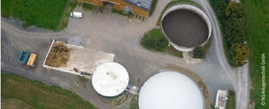
Eine Biogasanlage mit offenem Gärrestlager
