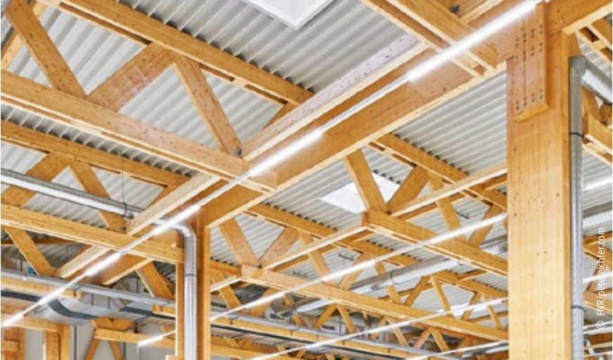
Rundum nachhaltiger Holzbau: Verwendung biobasierter und emissionsfreier Klebstoffe bei großen Spannweiten
